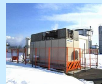
Digester gas-fed PAFC ( Yamagata City )
